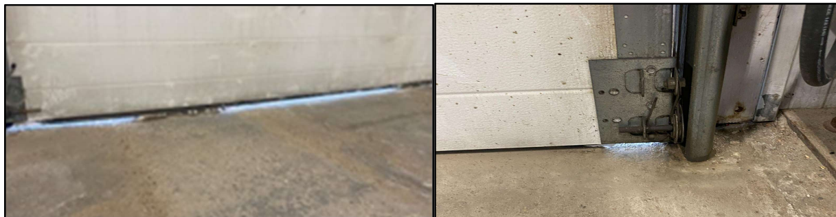
Fig. 3. Frost Accumulation on Door
